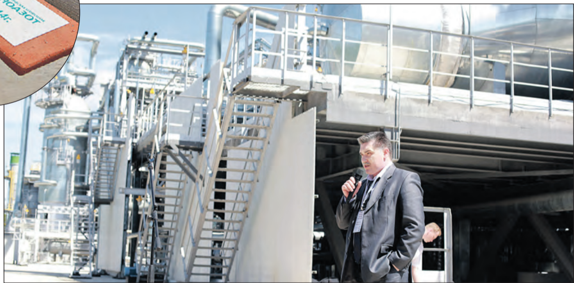
Эта метанольная установка запущена на «Щекиноазоте» в 2011 году. Новое производство будет ещё современнее и мощнее!
