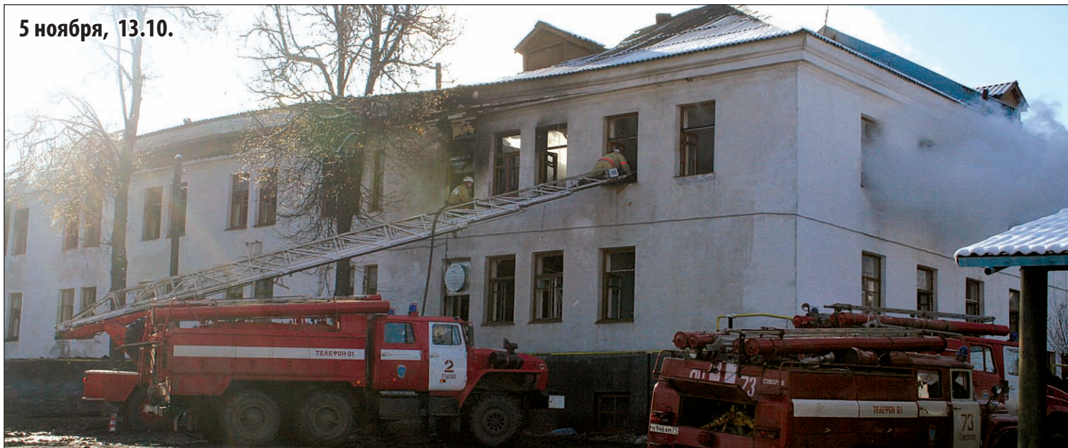
Пожарные боролись с локальными вспышками огня и через сутки после начала пожара.
