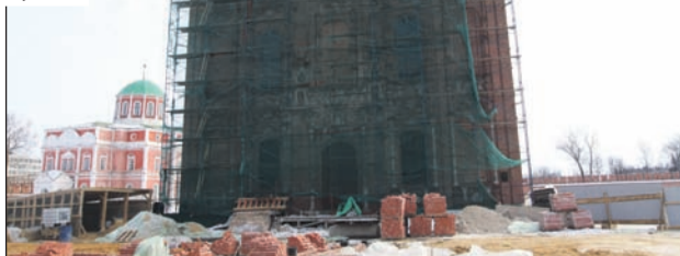
Строительство колокольни Успенского собора завершится к 1 сентября 2014 года
