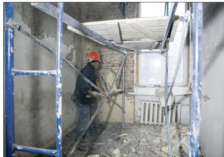
Работы предстоит много. Сейчас строители проводят демонтаж.
