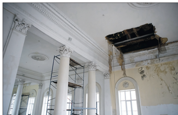
Колонны и лепнину сохраняют, в остальном здании будет не узнать.
