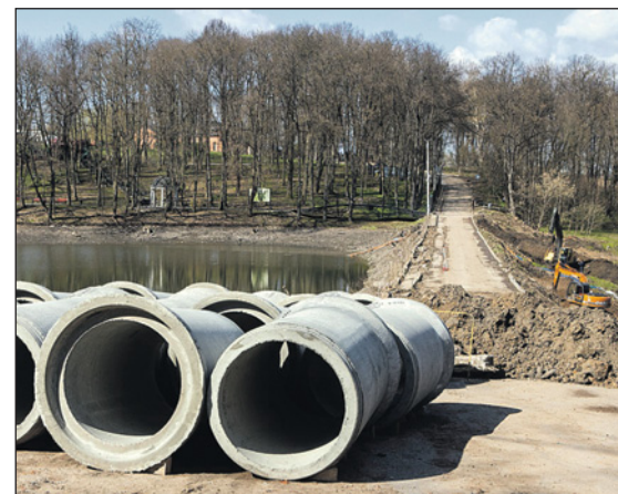
Работы на плотине в Платоновском парке завершатся в октябре 2022 года.
