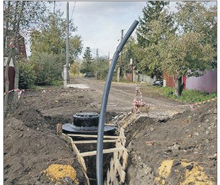
По региональной программе «Чистая вода» в Узловой строят новый 5-километровый водовод для трех улиц. Это 2000 жителей.
