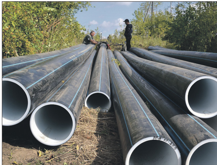
7 км водовода будут прокладывать до поселка Правда Новомосковского района. Работы закончат к 15 февраля 2020 г.
