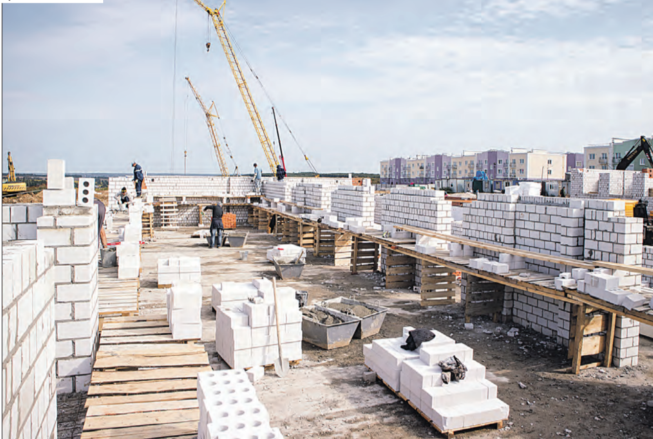
Общий вид стройки, фото от 11.09.17.
