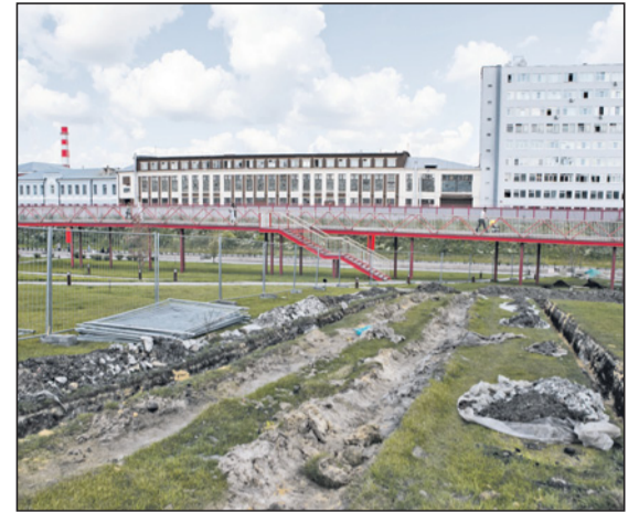
22 июля, Казанская набережная. Идет работа по прокладке новой ливневой канализации. Работы завершат через 15 дней.
