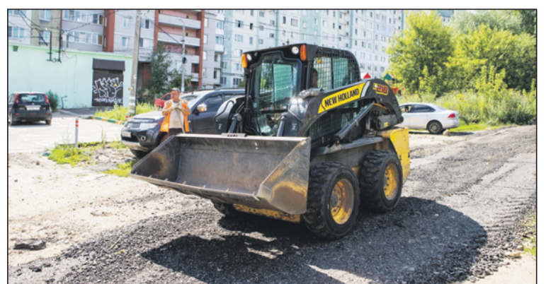
Ремонт дороги вдоль частного сектора протяженностью около километра в Рабочем проезде.
