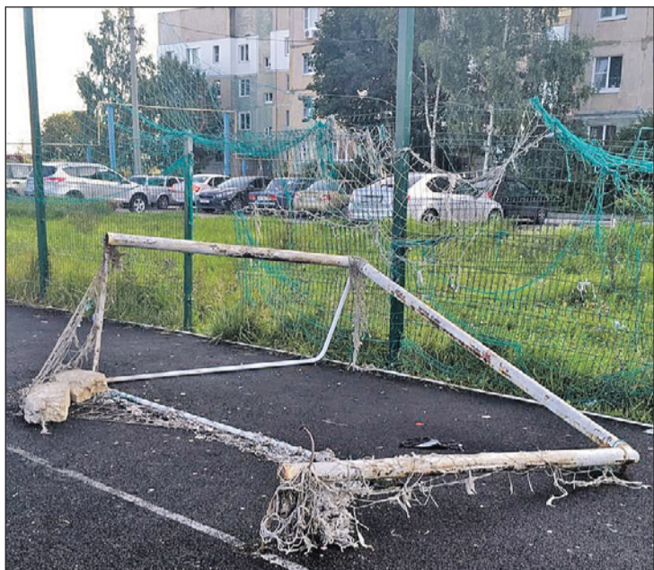
Ворота держались за счет уложенных на нижнюю опору камней. Несчастный случай был неизбежен.
