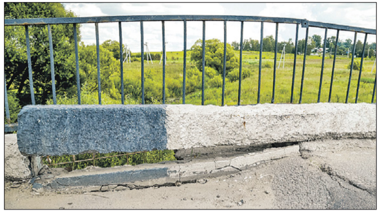
В одном месте дорожное полотно просело примерно на 25-35 см.
