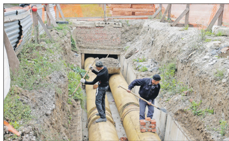
Тула, ул. Приупская. Работы по замене теплосетей в городе завершены на 75%.
