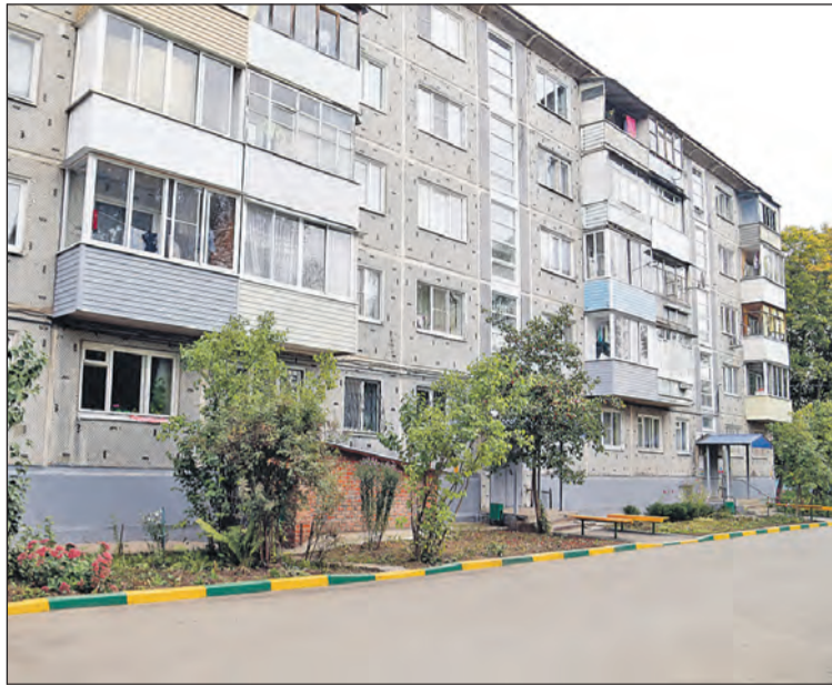
Тула, ул. Новомосковская, 19. По программе благоустройства дворовых территорий здесь появился новый асфальт и парковка.
