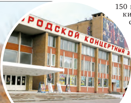
На фасаде ГКЗ сделают подсветку.
