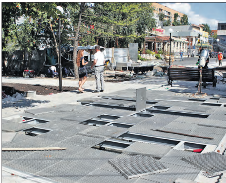
Монтаж «сухого» фонтана на Красноармейском проспекте почти завершен. Уже через пару недель он начнет радовать туляков.
