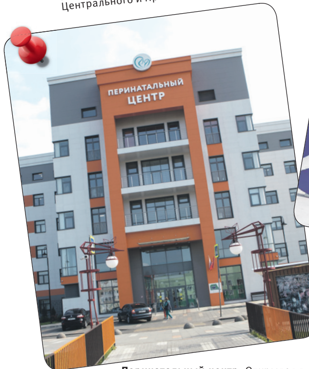
Перинатальный центр. Открылся в марте 2022 года. Это первый в регионе крупный объект в системе родовспоможения, построенный за последние 35 лет. За время работы в нем родилось более 8000 малышей.
