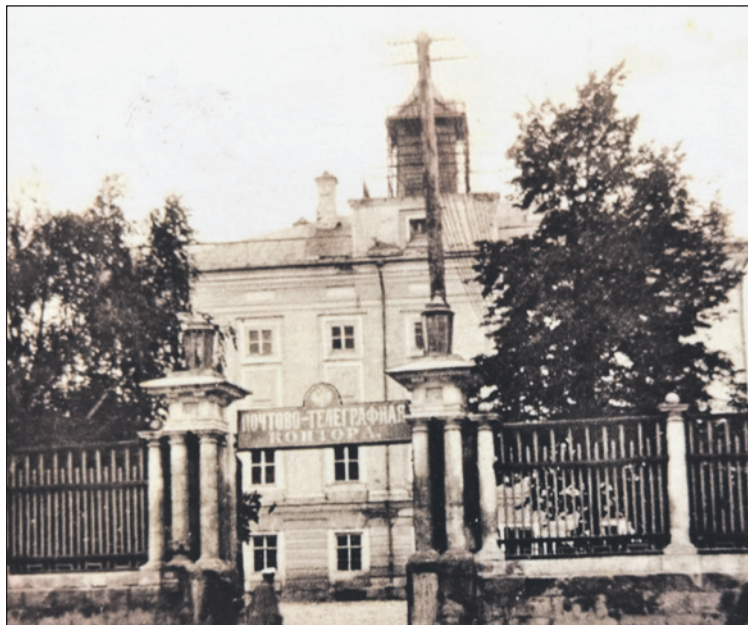
Вход в почтово-телеграфную контору.
