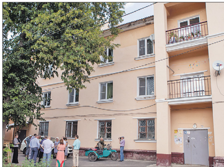
Ясногорск, ул. Комсомольская, 3. Крыша дома после ремонта проверку дождями выдержала!
