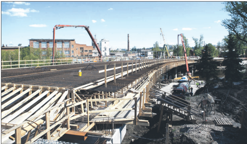
Мост через Упу сдадут к сентябрю 2024 года.
