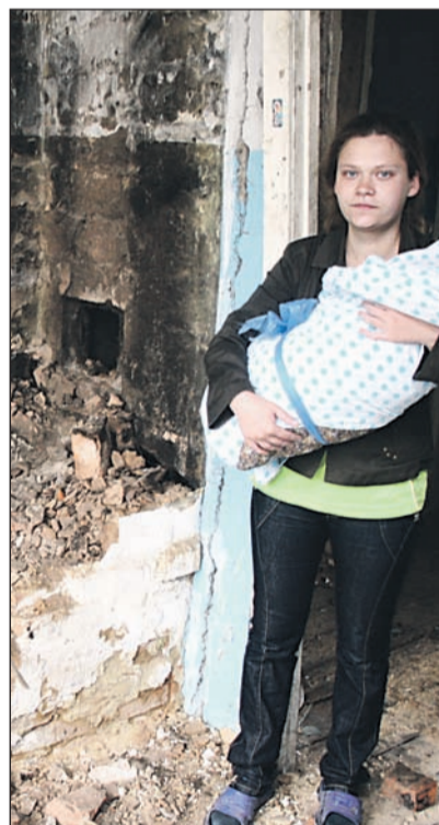
Печка в квартире Титовых разрушена, и другого отопления нет.
