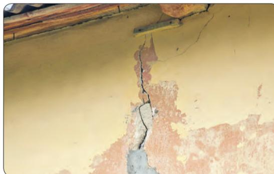
На фасаде жилого здания под крышей видны трещины.
