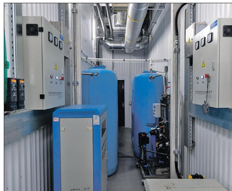
Вода для мойки очищается и минерализуется, чтобы на машинах не оставалось пятен и разводов.
