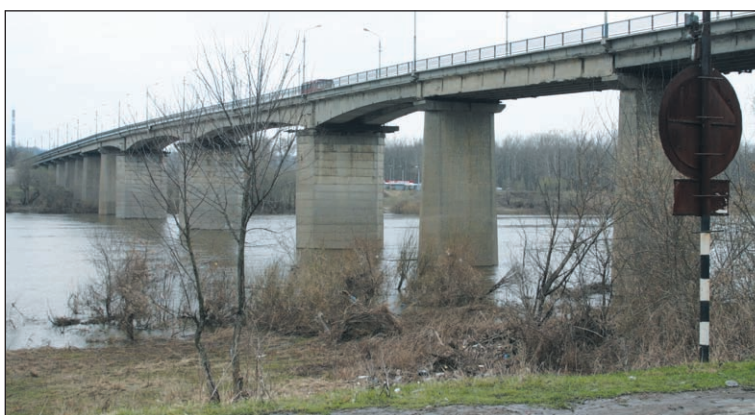
10 октября 2008 г., мост через реку Оку в Алексине. В следующем году рядом со старым мостом начнется строительство нового.
