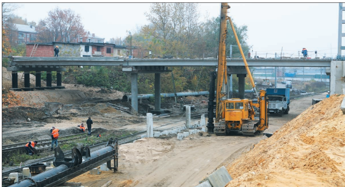
10 октября 2008 г., эстакада Одоевского путепровода. Строительные работы на подъезде к путепроводу идут полным ходом.
