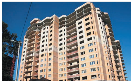
Жилой комплекс «Оружейная Слобода» возводится в центре Тулы, на ул. Михеева.
