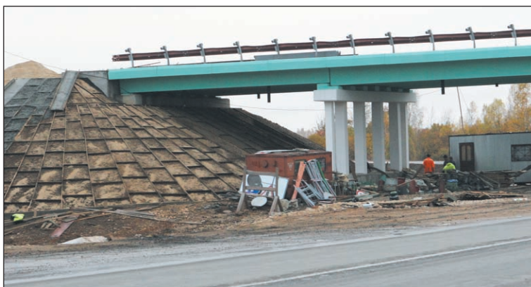
13 октября 2008 г., мост на Калужском шоссе. После окончания ремонта мост расширится и на нем появятся пешеходные дорожки.
