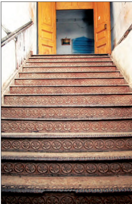
На второй этаж ведёт чугунная лестница, изготовленная на местном чугунолитейном заводе.
