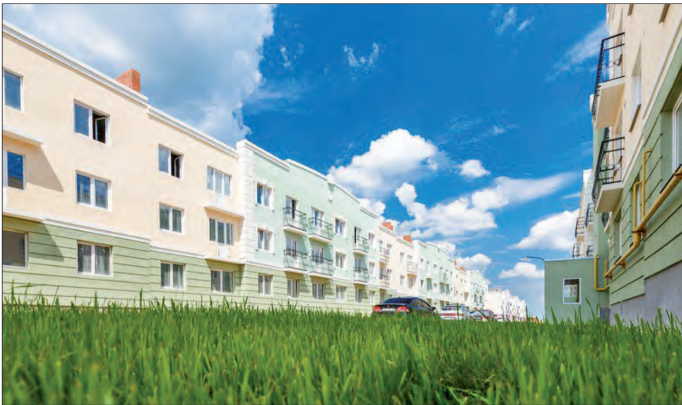
В Северной Мызе – красиво, чисто, уютно.
