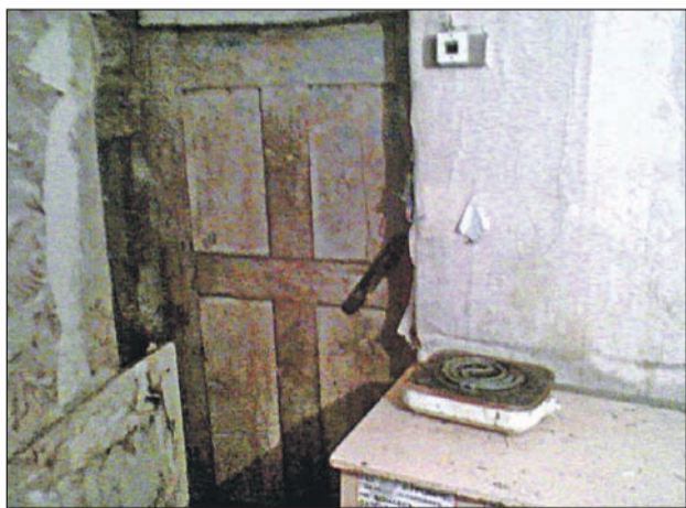
...и изнутри: тумбочка и электроплитка – для рабочих кирпичного завода почти что номер люкс!
