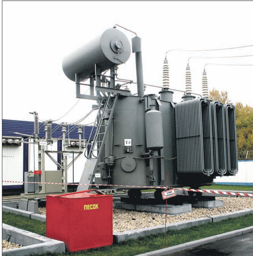
При строительстве подстанции «Стечкин» использовались новейшие отечественные разработки.
