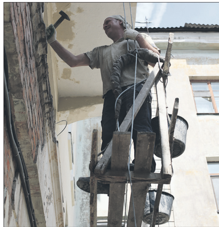
Ремонт фасадов выполняется на домах в последнюю очередь, потому что они в меньшей степени влияют на сохранность самого здания.
