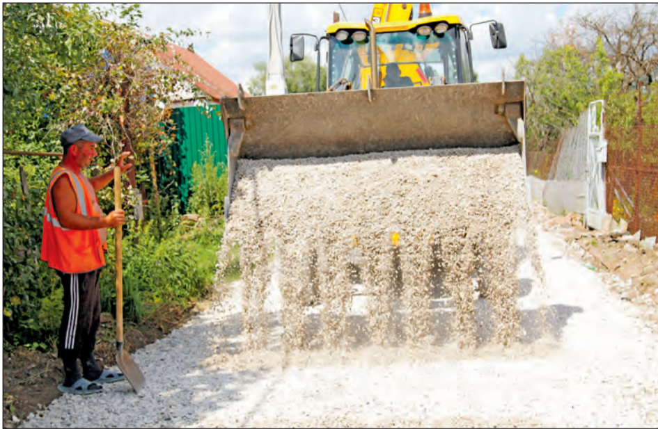
18 июля 2014 года, посёлок Шатск. Работы по ремонту дорог в Ленинском районе выполняет московский подрядчик ООО «Дорстрой-35».
