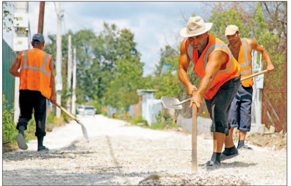
На улице Пролетарской в Шатске всю работу по выравниванию дорожного полотна. Затем здесь появится асфальт. Гарантия на дорогу – 4-5 лет.
