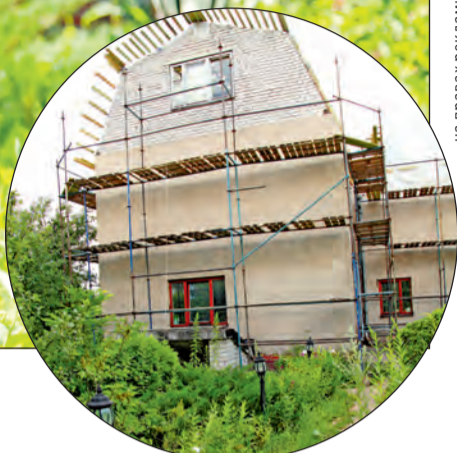
Строительство дома идёт полным ходом.
