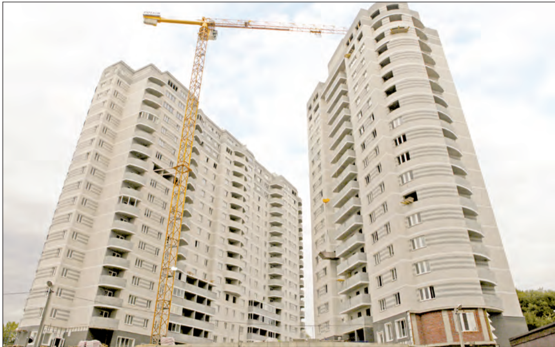
Строительство ЖК «Макаренко» завершено, комплекс будет сдан в эксплуатацию в декабре. Покупатели квартир получают ключи уже к новогодним праздникам!
