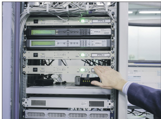
Так выглядит современный передатчик теле- и радиосигнала.
