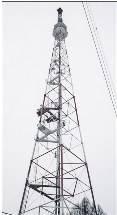
Мачта вся усеяна «тарелками» – принимающими и передающими сигнал.
