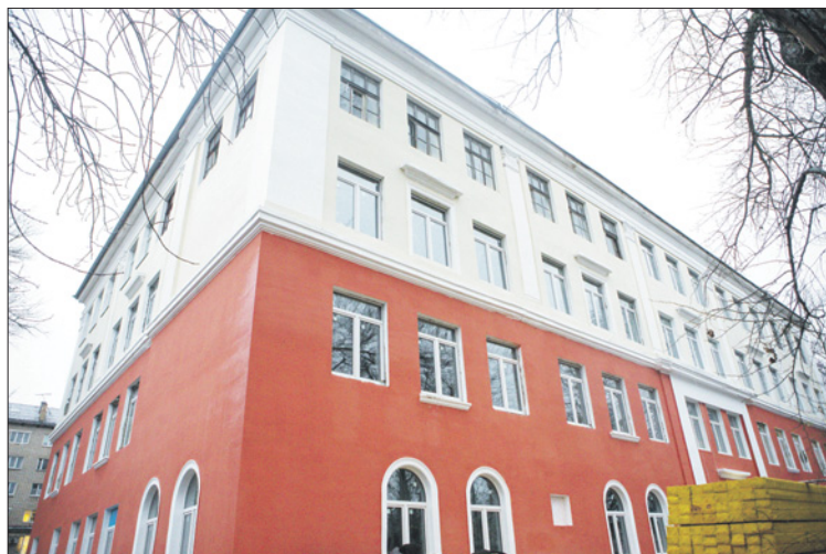
Сейчас продолжается ремонт фасада, работы по оштукатуриванию внутренних стен, замене полов и монтажу черного гипсокартона.
