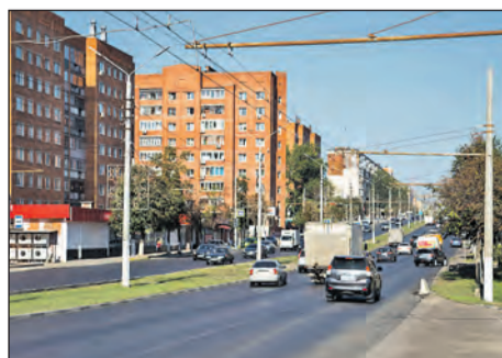
Капитальный ремонт ул. Ложевой. Выполнены: ремонт люков смотровых колодцев, замена бортового камня, устройство подходов к пешеходным переходам, ремонт тротуара и нанесение дорожной разметки.
