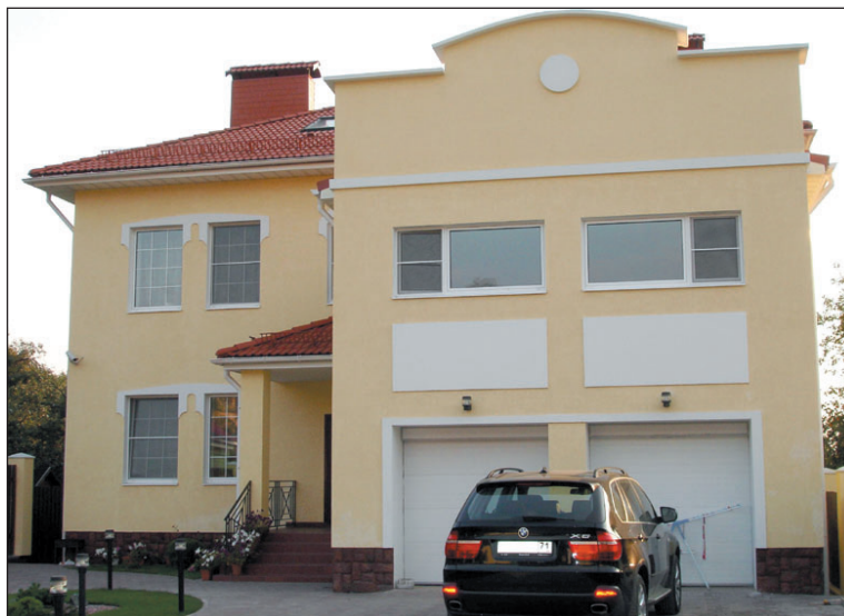
Мало построить красивый дом – нужно грамотно выполнить в нем все инженерные системы. И тогда комфорт будет радовать вас долгие годы.
