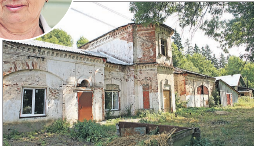
Каретный двор усадьбы похож на маленький дворец. Сейчас здесь жилой дом. Когда-то каретный двор соединялся с усадьбой специальным коридором.
