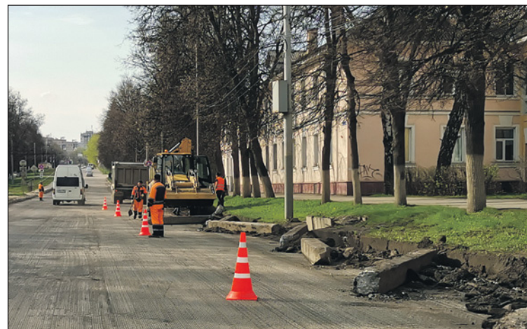
Протяженность ремонтируемого участка ул. Metallургов – 3,97 км, площадь – 63 тыс. кв. м.
