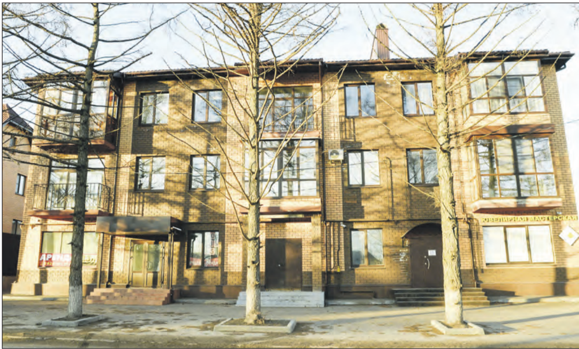
Владельцы квартир в доме №43 по улице Станиславского надеются, что суд даст застройщику шанс исправить имеющиеся нарушения.
