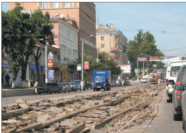
Тула, ул. Октябрьская, лето 2008 года. Капитальный ремонт трамвайных путей продолжался два месяца.
