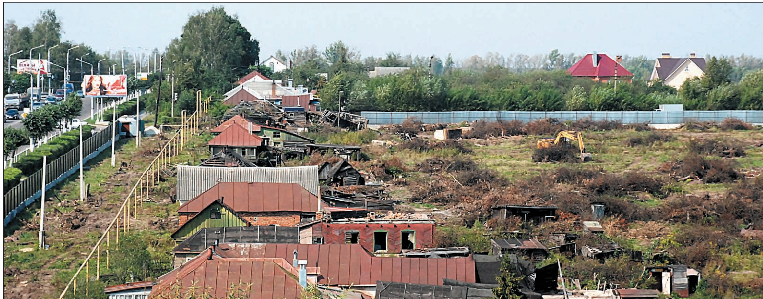
Жителей более 40 частных домов на ул. Октябрьской уже переселили в новое жилье, а на этом месте начали возведение жилого комплекса.
