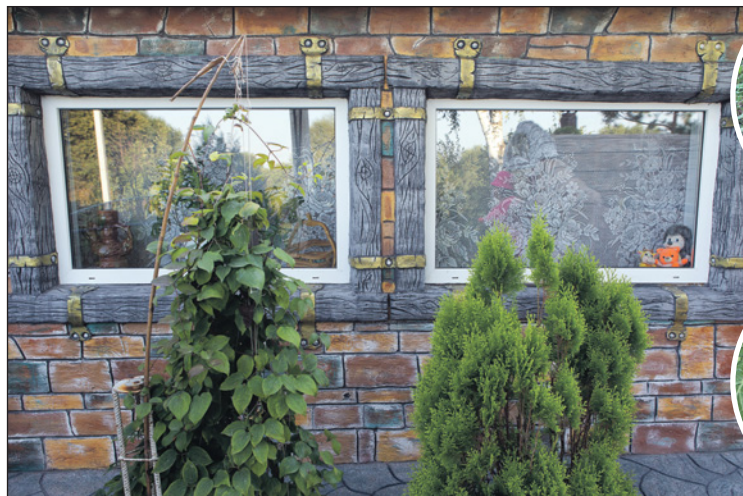
Фасад дома – ни дать ни взять дорожный кирпич, а на самом деле – тоже арт-бетон.
