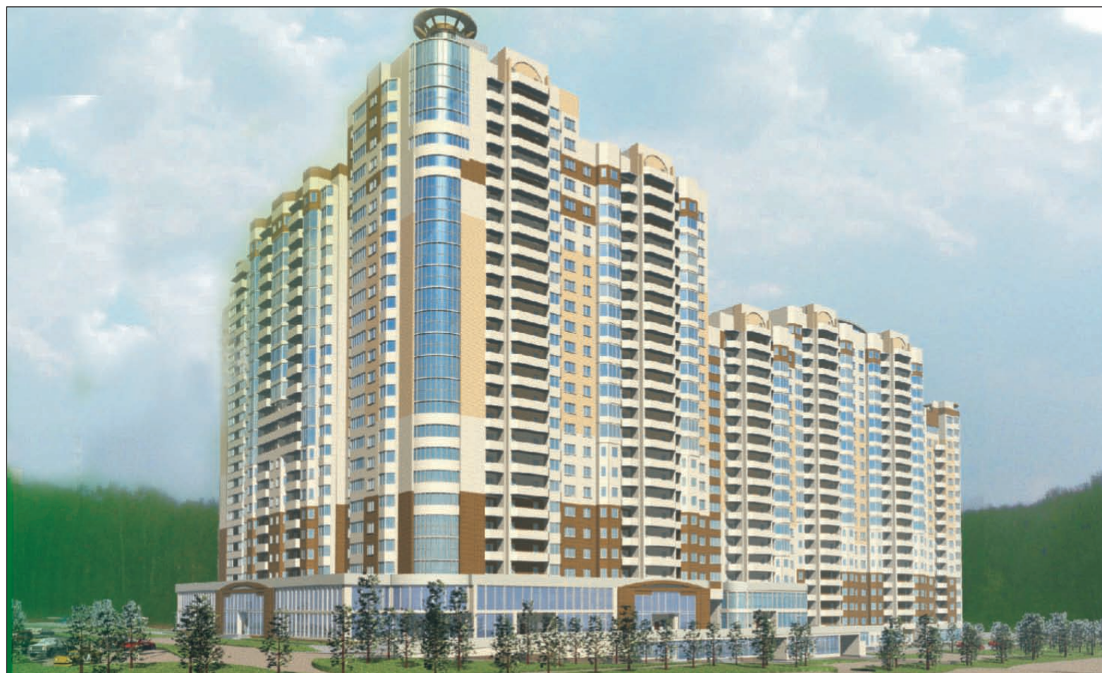
Ключи от новых квартир в жилом комплексе «Платоновский лес» первые жильцы дома получают уже в марте - апреле следующего года.
