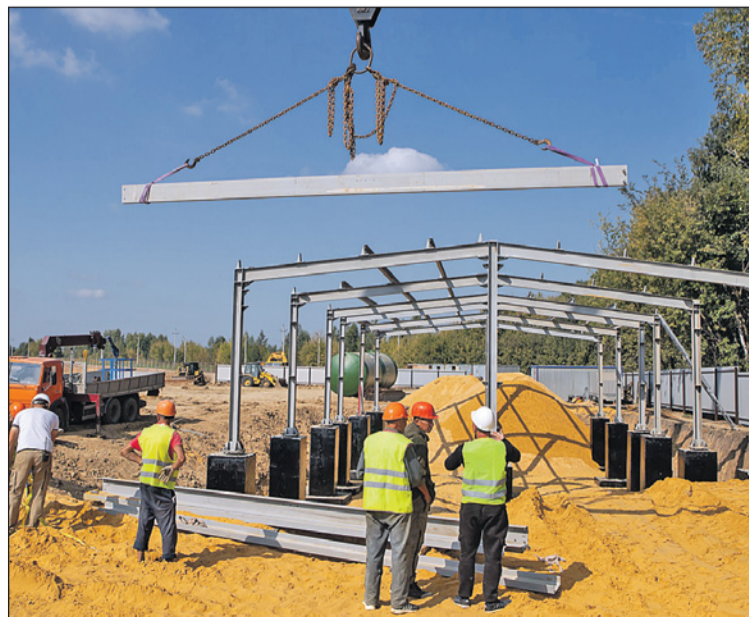
Строительно-монтажные работы на производственном комплексе по утилизации отходов планируется завершить в конце сентября 2019 года.
