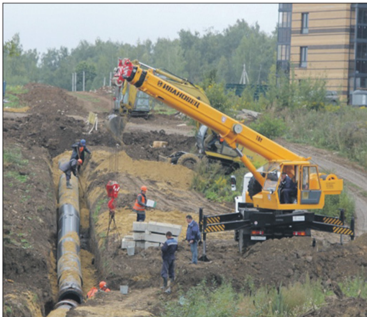
Замена магистрального трубопровода на Медвенско-Осетровском водозаборе гарантирует надежное водоснабжение пролетарцам.
