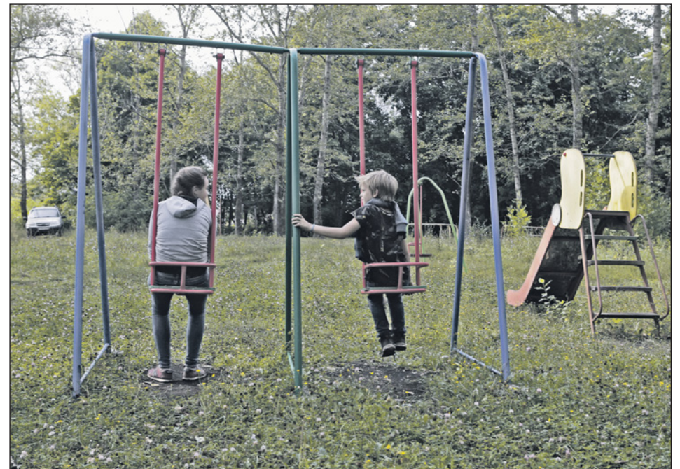
Даже сидеть на качелях не безопасно. Они не закреплены и могут упасть от неосторожного движения.
