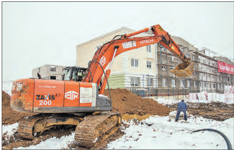
Установка оснований канализационных колодцев.
