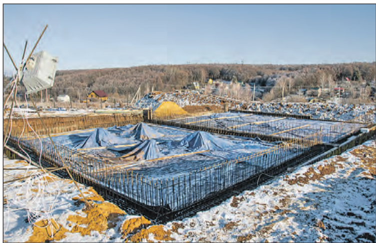
Строительство резервуаров водохранилища.
