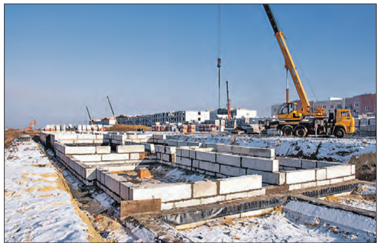
Ведутся работы по монтажу и гидроизоляции фундамента дома №19.
