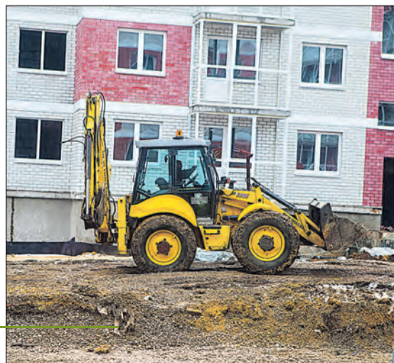
Дома первой очереди готовы, идёт благоустройство дворов. Ключи – весной!
