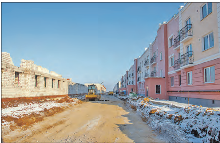
Ведутся работы по благоустройству территории между домами.
