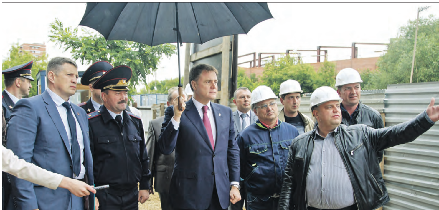
Перед встречей с жителями Владимир Груздев осмотрел строительство первого за долгие годы в Туле муниципального дома.
