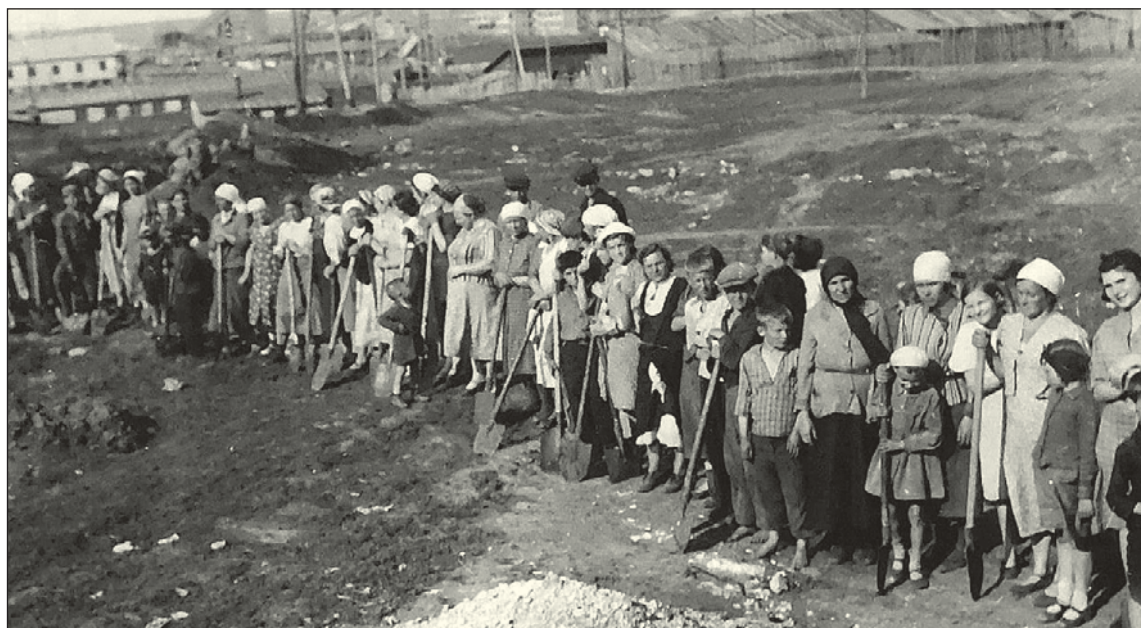
Население Сталиногорска вышло на строительство убежищ. Лето 1941 г.
