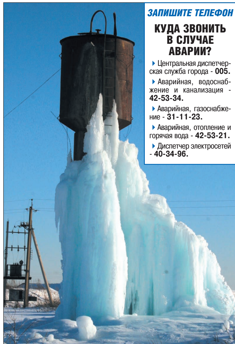
Водонапорная башня в деревне Анишино Веневского района: утечка воды при резком похолодании превратила ее в айсберг.
