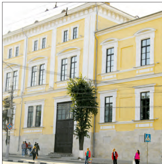
Тула, Дом офицеров. Вот так выглядит обновлённый фасад исторического здания. Теперь это украшение проспекта Ленина.
