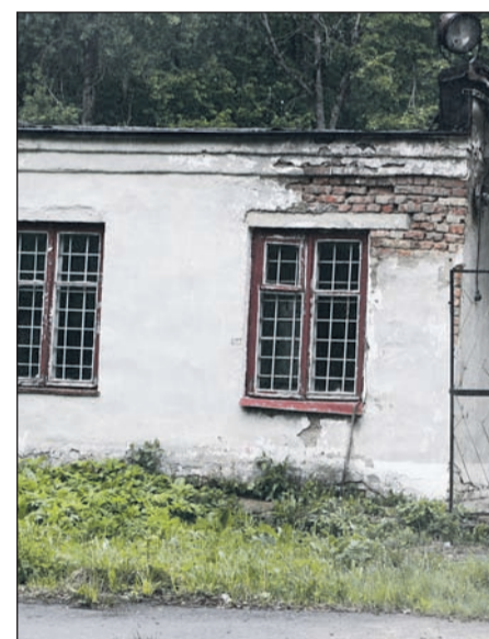
Контрольно-пропускной пункт Тулы-50.
