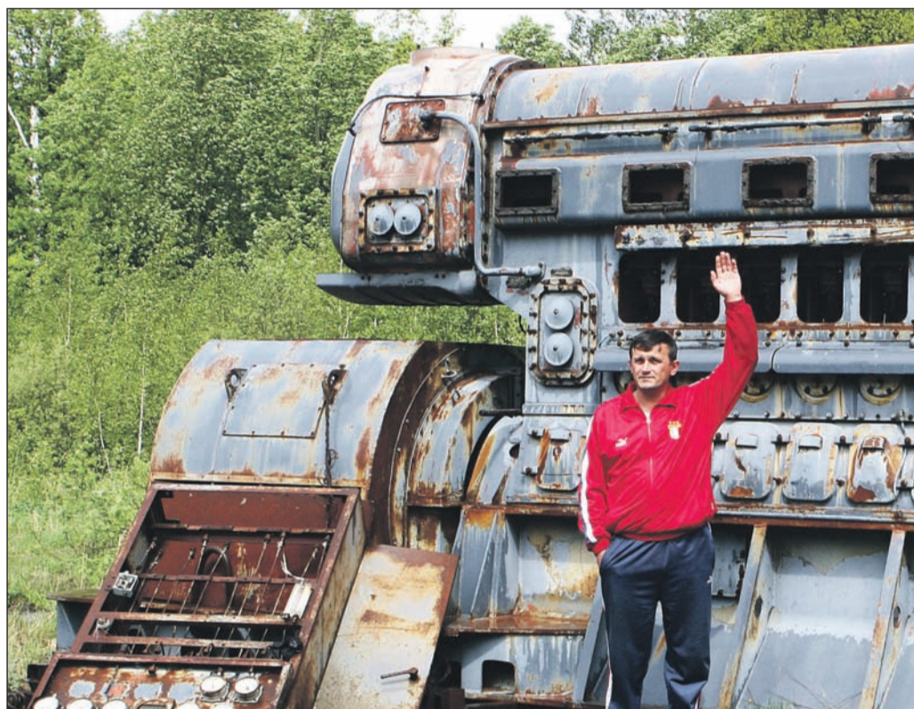
Если электричество в Туле-50 «вырубалось», по словам местного жителя Игоря Салова, дизельная станция обеспечивала ток весь военный городок с инфраструктурой.
