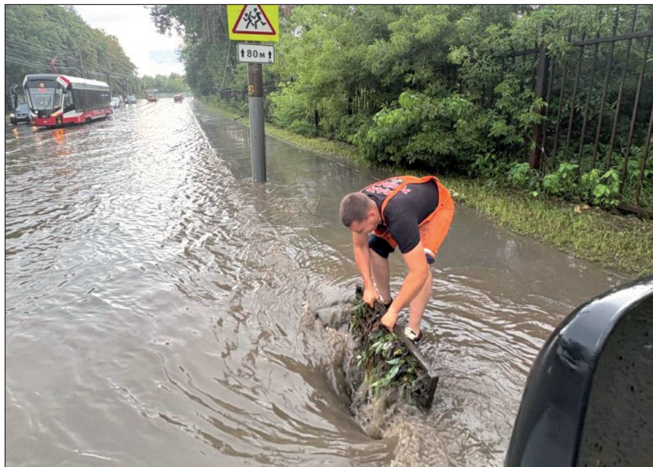
Дорожные рабочие чистят ливневки от листьев и бытового мусора.
