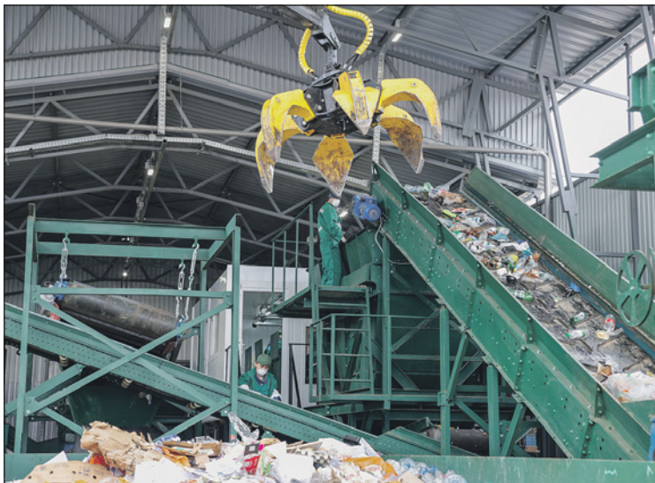
В апреле состоялся старт первой очереди экотехнопарка «Тула» по переработке мусора.
