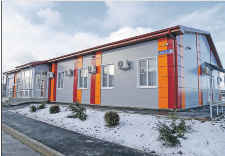
Амбулаторию начали монтировать в октябре 2019 года, а 25 декабря 2019 года здесь уже принимали первых пациентов.
