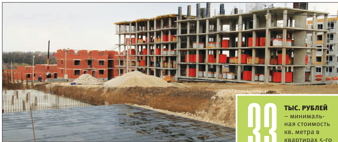
Строительство пятого квартала второй очереди микрорайона. Уже залиты фундаменты домов, начался монтаж подвалов.
