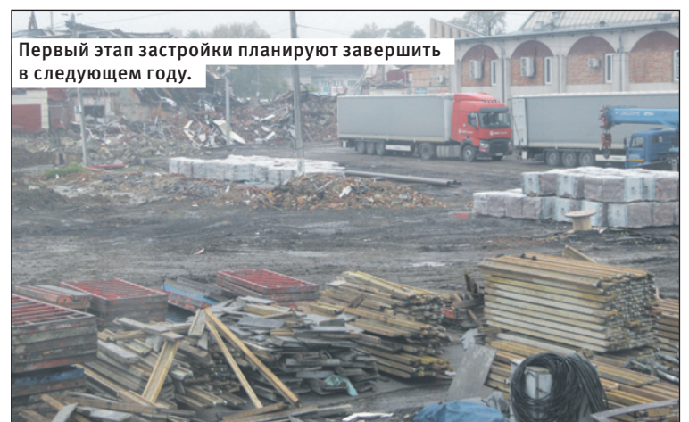
А в паре метров от них кипит стройка.
