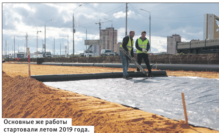
Подготовка к строительству началась в 2018 году.
