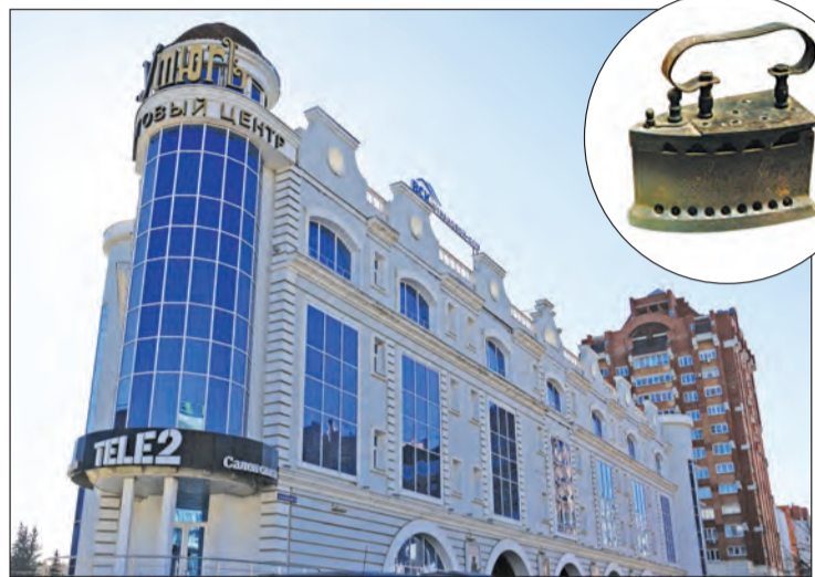
Утюг. Наследовал название от старого дома-утюга, стоявшего здесь в середине XX в. Тула, ул. Демонстрации, 1-г.
