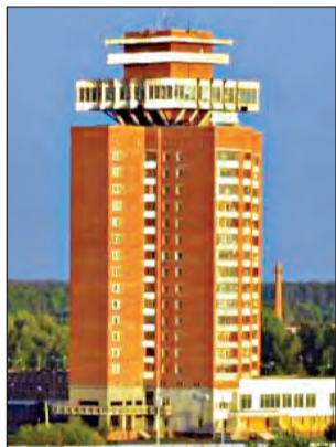
Одеколон (Йошкар-Ола, Россия). 15 жилых этажей плюс офисная надстройка. Самое высокое здание в городе.
